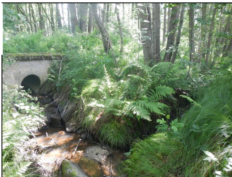
Foto č. 6: Soutok hlavních ramen Krčelského potoka. V pozadí fotografie pohled na čelo trubního propustku DN 600.
